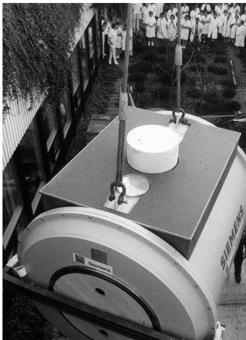
Indhejsning af den første MR-skanner den 11. december 1984. Skanneren var 3 meter lang og vejede over 7 tons. Kilde: Polfoto.
