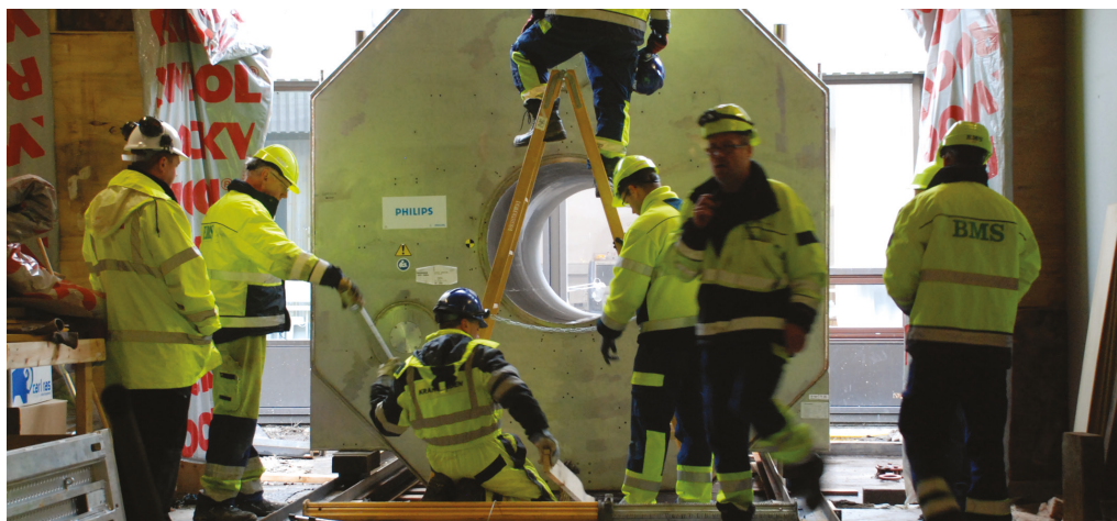
Indbaksning af den 44-tons tunge magnet til 7 tesla skanneren
